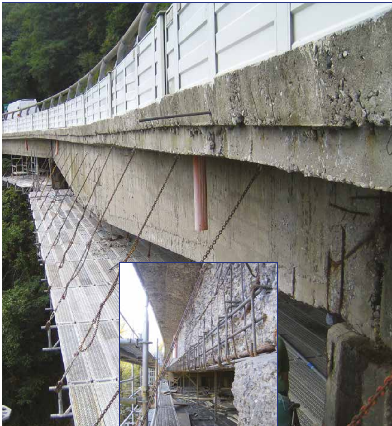
Autostrada Torino Savona. Viadotto Termoia.
