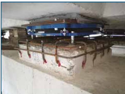
sollevamenti di strutture
