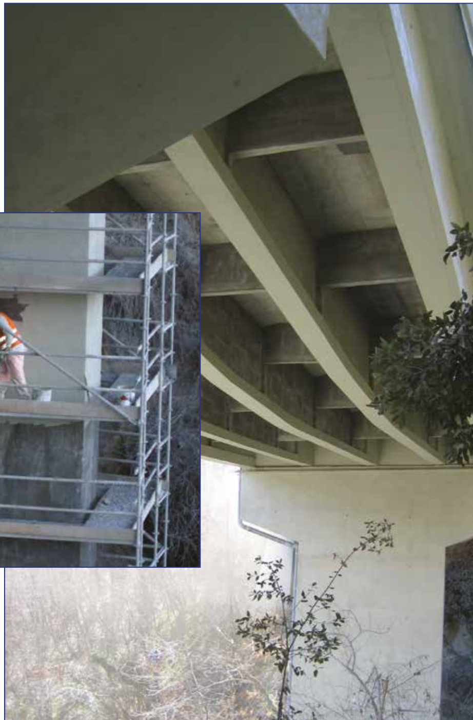
Autostrada Torino Savona. Viadotto Ternoia.
