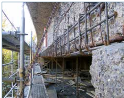
protezione anticorrosiva strutture metalliche
