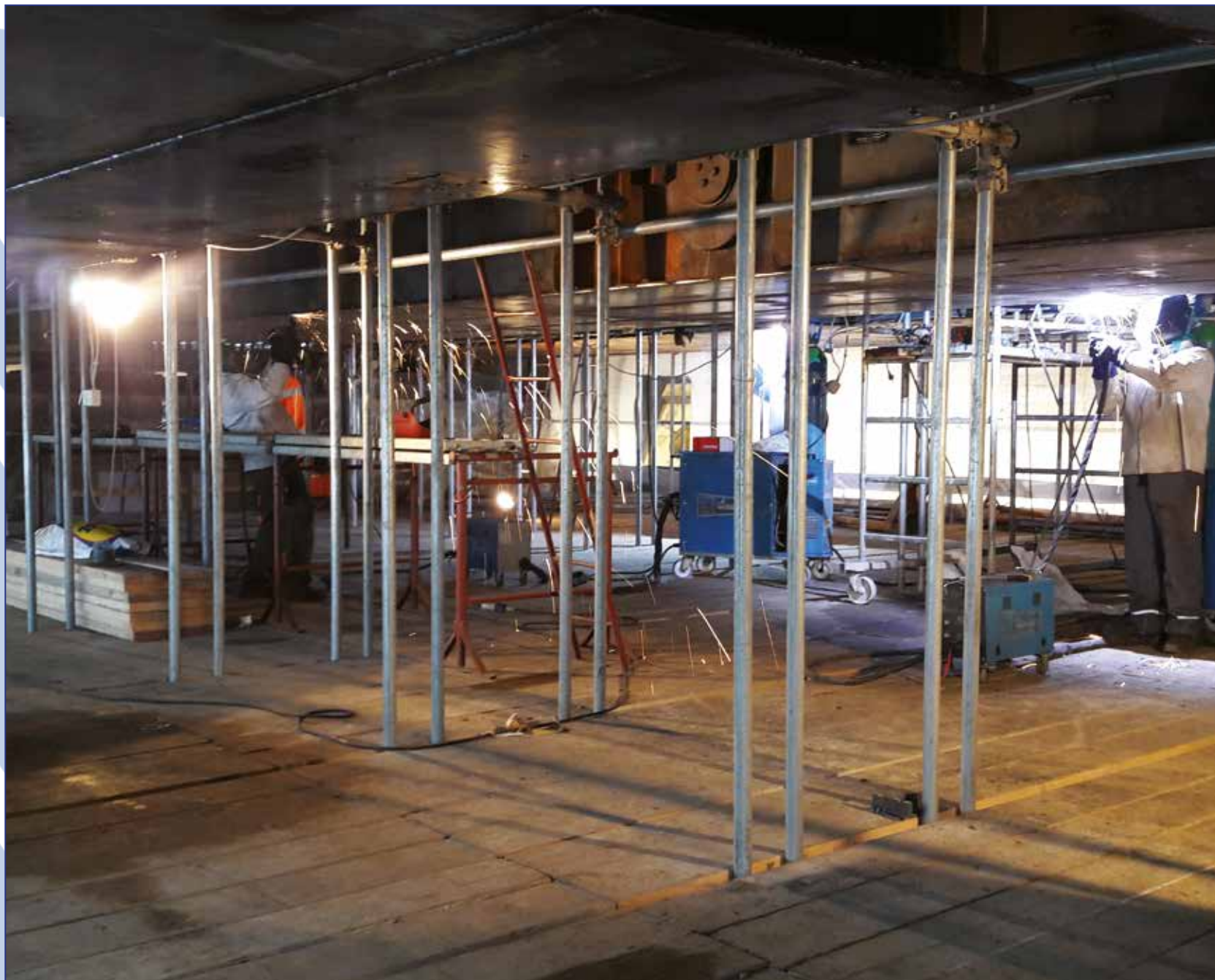
Autostrada Milano Bologna. Ponte sul fiume Po.
