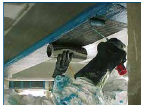
rinforzo strutture con fibre in carbonio
