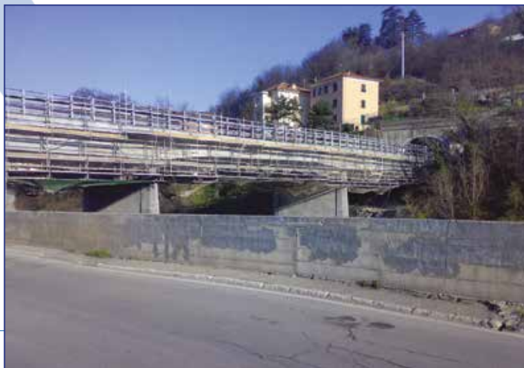
Autostrada Genova Imperia. Viadotto Ronco Scrivia.
